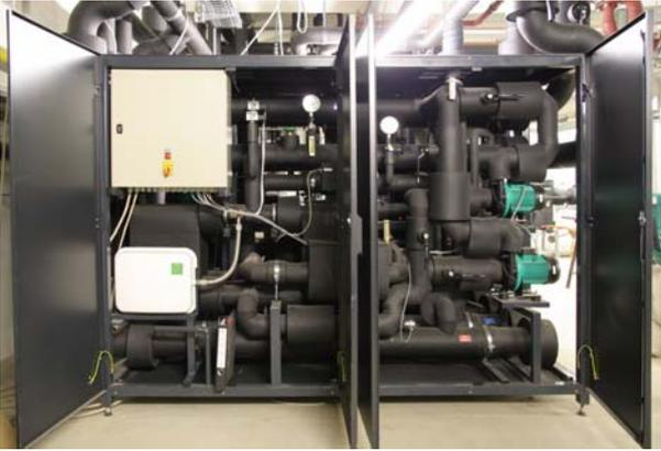
**Abb. 2: Das „Innenleben“ eines Wärmetauschers**
