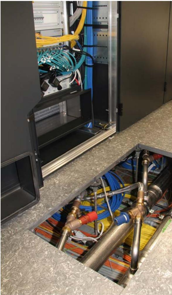
**Abb. 4: Die Serverschränke sind über flexible Schläuche an den Kühlkreislauf angeschlossen**
