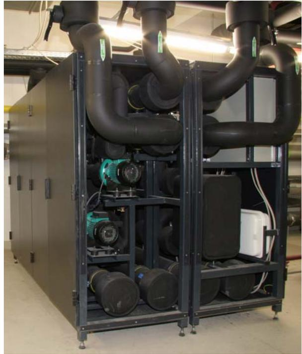
**Abb. 1: Zwei Wasser-Wasser-Wärmetauscher mit je 100 KW Leistung versorgen das neue Rohrleitungsnetz mit 12 Grad kaltem Wasser**
