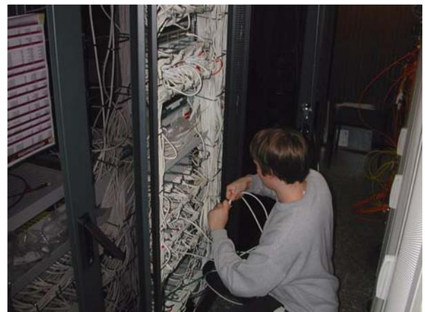
Abb. 3: Patchen von Netzwerkverbindungen
